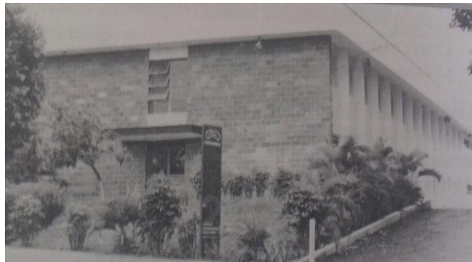
Figura 3 - Prédio de funcionamento da FADEC
