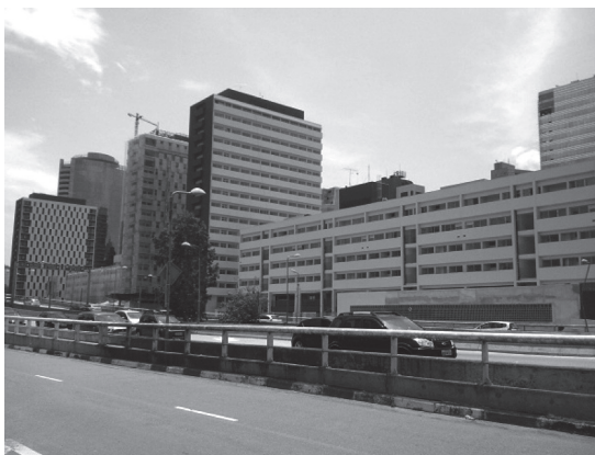
Figura 4 – Residencial Jardim Edith (em construção)
